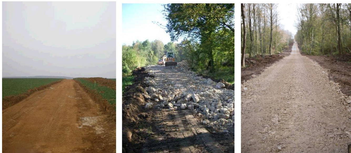
Photo 7: De gauche à droite, opération de décapage ; mise en place de la couche de fond de forme ; mise en place de la couche de finition (Source : RES)
