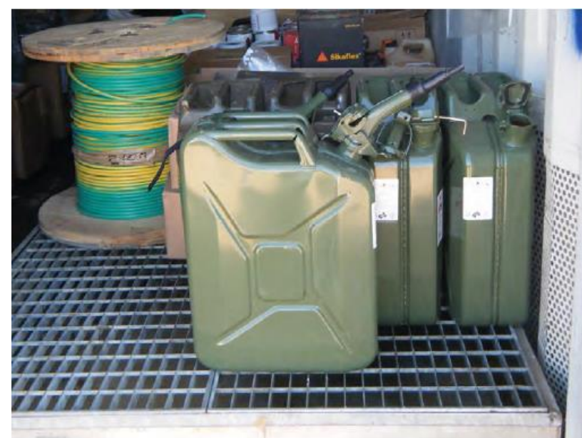
Photo 6: Exemple de stockage de carburant sur bac de rétention
